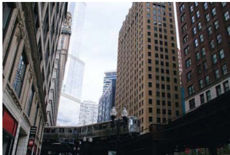
老朽化はなほだ しい線路を、ガ タゴトと元気に 走る「ルート66」
